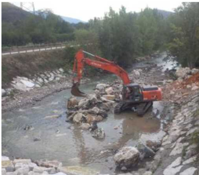
Lavori di prevenzione nell'alveo di un fiume
